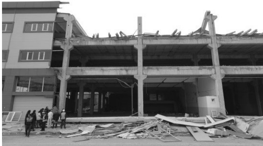
写真-8 建設中の工場建物 (Kahramanmaraş)
