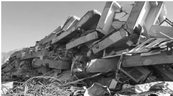
写真-14 パンケーキ倒壊した7階建てRC造住宅
