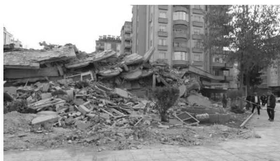
写真-3 崩壊した9階建てRC造アパート
