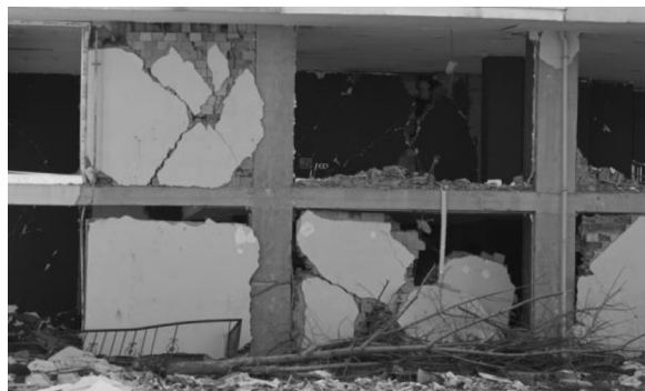
写真-2 地震に耐えた建物の1・2階の壁
