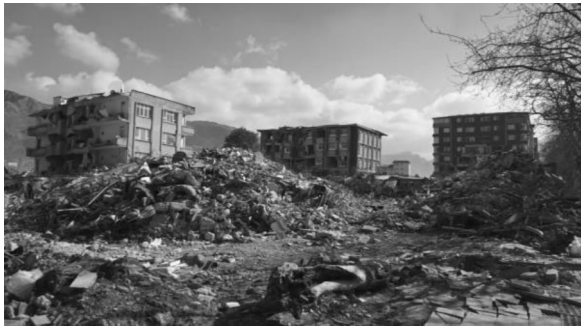
写真-12 Antakya 市西側で倒壊率が高い領域
