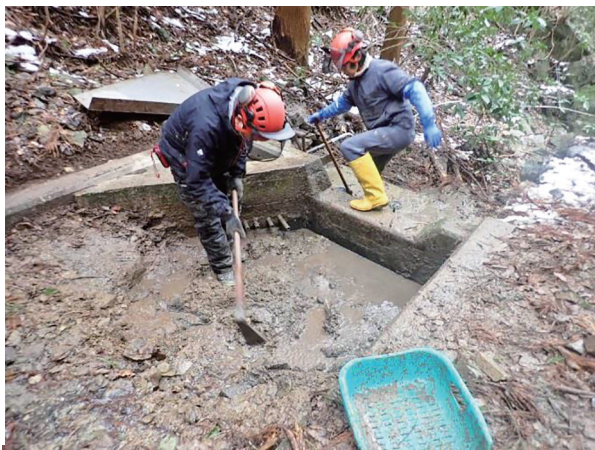
（取水施設の土砂取り除き）
