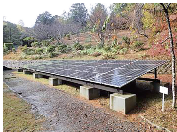
10kW に増設した太陽光パネル
