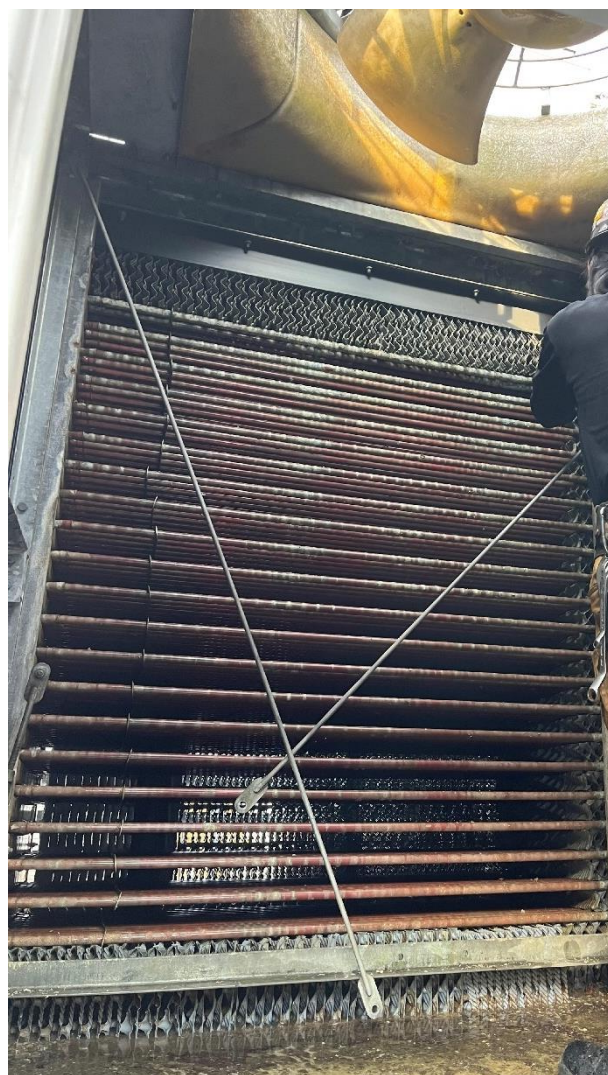
図5. 充填材を取り外して銅管コイル周辺の点検等をしている様子
