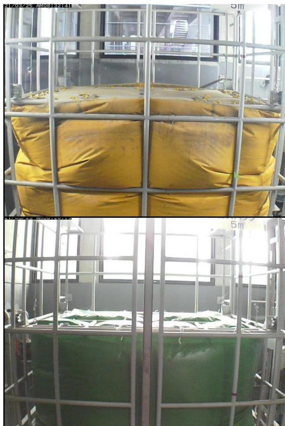
図2. (上) 交換前の容積5.2 m 3 のガスバッグ。ガスバッグと外枠が擦れ合っていた。(下) 交換後の容積4.1 m 3 のガスバッグ。ガスバッグと外枠の接触が低減された。
