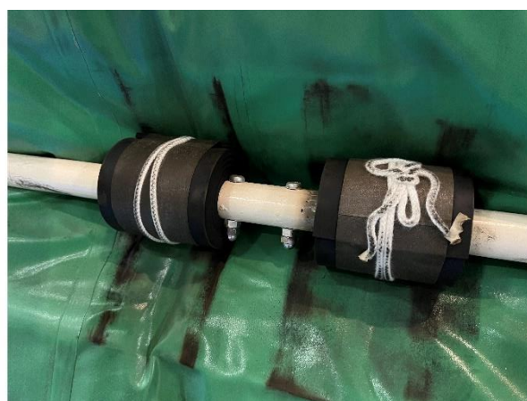
図3. 液化室ガスバッグのボルト対策
