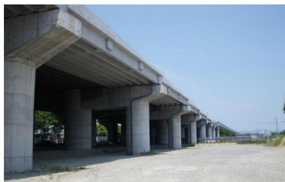
写真 2.2-3 PC 桁を増設した改築工事<sup>12)</sup>
