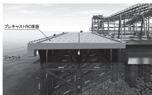
図 2.2-15 海上栈橋への適用事例<sup>13)</sup>
