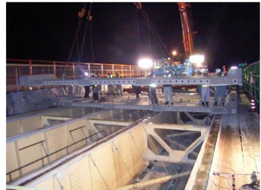
写真 1.4-2 新設床版の架設状況<sup>8)</sup>
