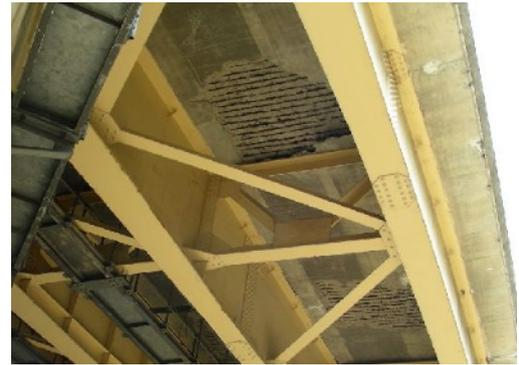
写真 1.4-1 床版下面の劣化状況<sup>8)</sup>
