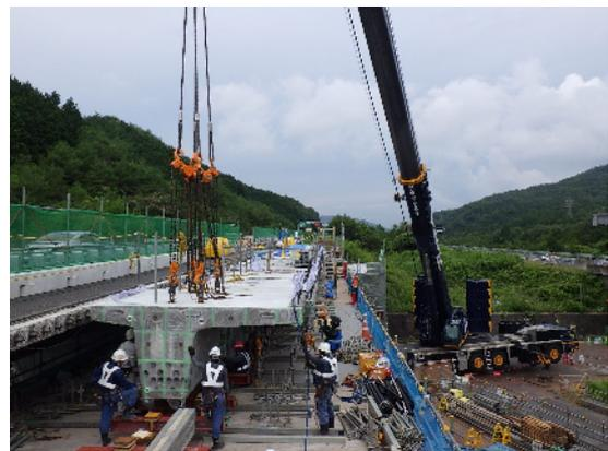
写真 5.4-9 主桁セグメント据付け状況
