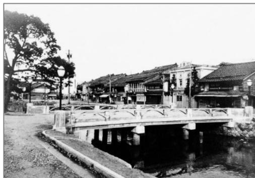
写真 1.2-2 我が国初の PC 橋である長生橋<sup>3)</sup>
