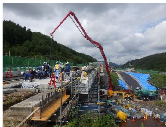
写真 5.4-11 BFS 高流動コンクリートの打設
