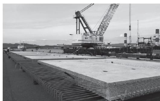
写真 2.2-8 海上栈橋に用いた RC 床版<sup>13)</sup>
