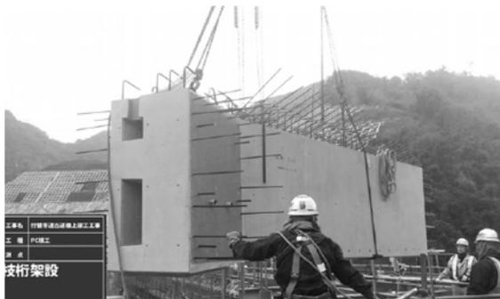
写真 2.2-6 プレキャスト桁部材の架設<sup>14)</sup>
