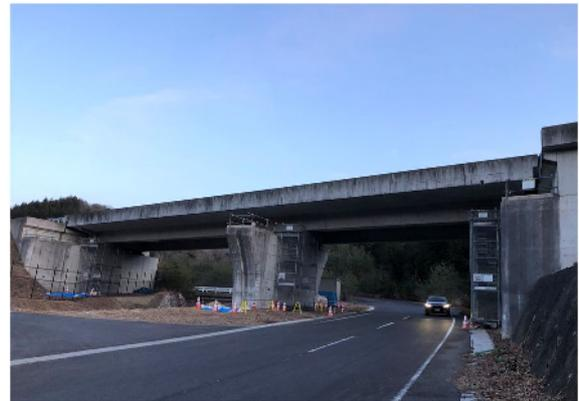
写真 5.4-1 拡幅工事前のつめた谷橋
