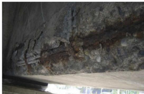
写真 2.2-1 補修箇所が塩害で再劣化した状況
