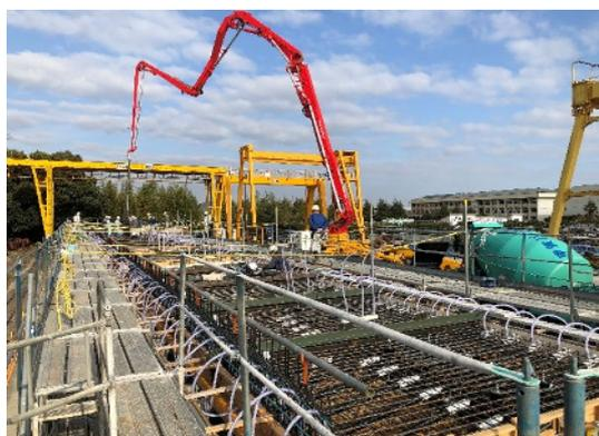
写真 5.4-6 セグメントのコンクリート打設
