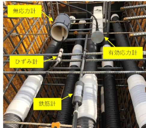
写真 5.4-14 計測機器の設置状況
