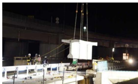
写真 2.2-2 塩害で劣化した PC 橋の撤去状況<sup>11)</sup>
