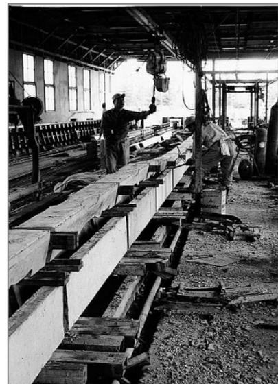
写真 1.2-1 PC マクラギの製造風景<sup>3)</sup>
