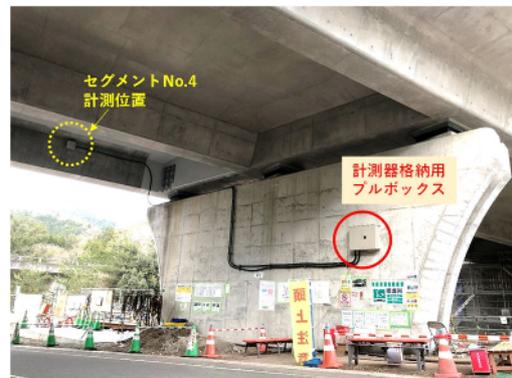
写真 5.4-15 実橋における計測状況
