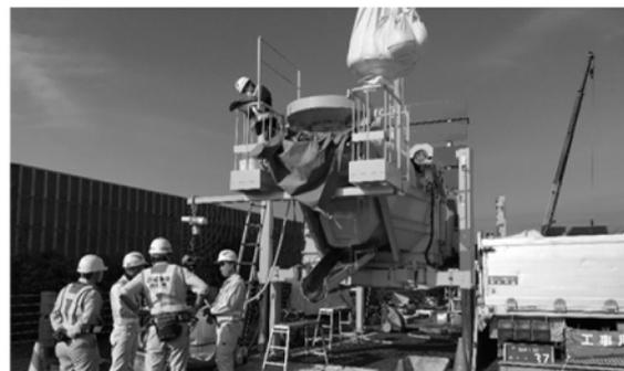
写真 2.2-7 移動式ミキサによる打設<sup>14)</sup>
