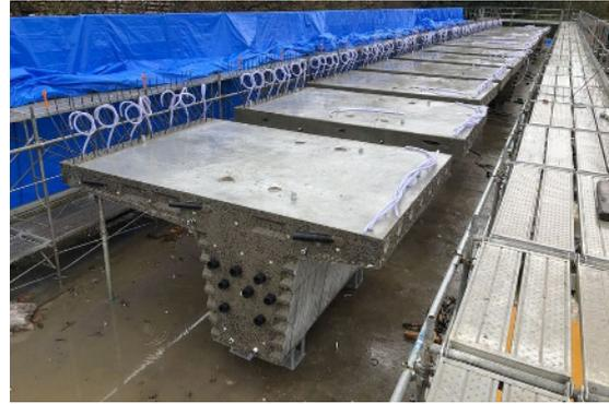
写真 5.4-7 セグメント製作完了
