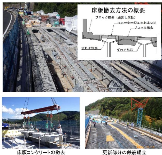
写真 1.4-4 PC 合成桁の床版打替え<sup>10)</sup>
