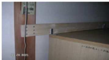
柱間に板を渡して固定
