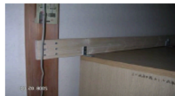
柱間に板を渡して固定
