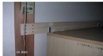
柱間に板を渡して固定
