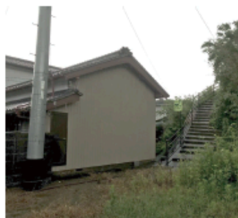
津波避難のため改修時に避難経路側に勝手口を新設（黒潮町）
