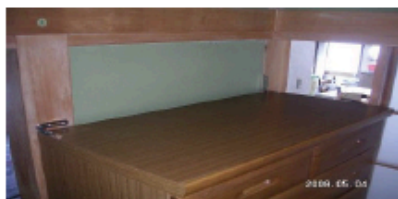
大きな家具は柱に直接固定
