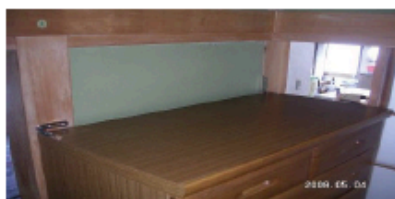
大きな家具は柱に直接固定
