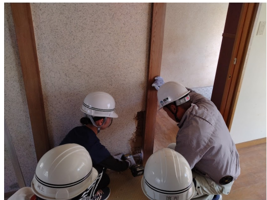
写真5 耐震改修DIYワークショップ2（大工の指導による金物の取り付け）
