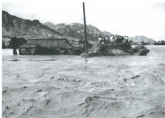
昭和26年災害（防府市上右田・本橋上流地区）
