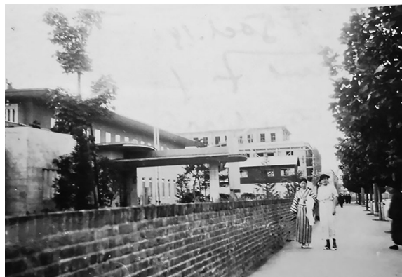
図 13 東大路通り沿いには当時路面電車が走っていた。 手前の建物が獨逸文化研究所。その奥に工事中の 学館が見える
