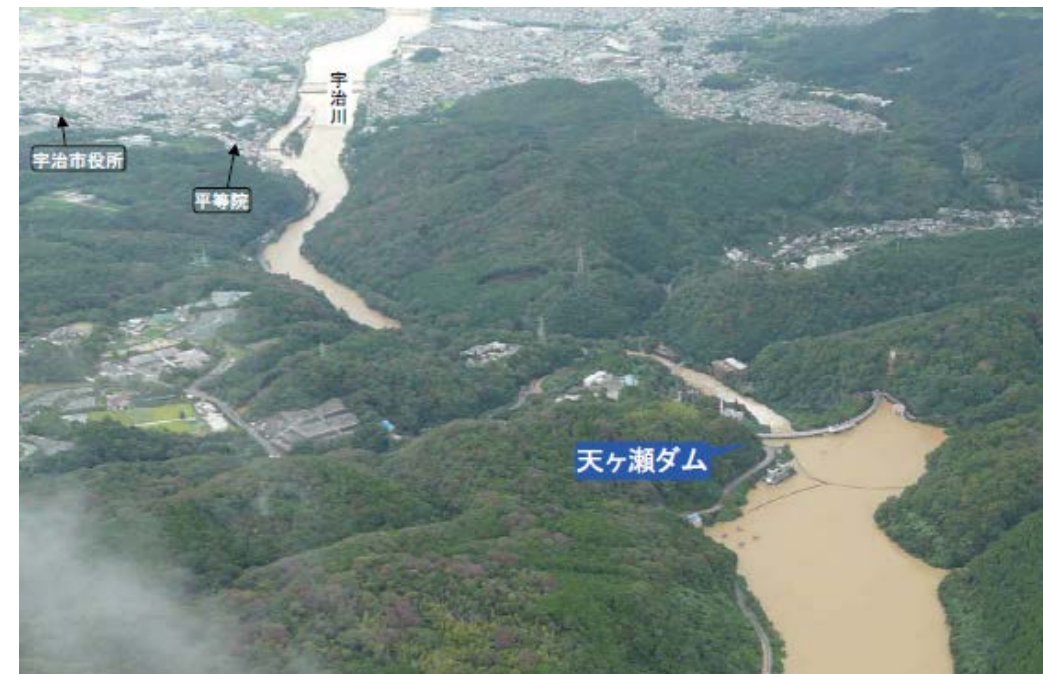
平成25年台風18号災害概要（国土交通省近畿地方整備局）
