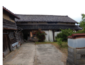
写真10 全壊した木造建物
