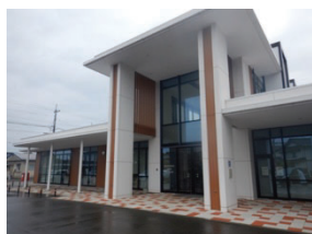
写真23 能登町内浦総合支所
