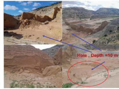
写真2 Abu Mansourダム（決壊後）と河床状況
