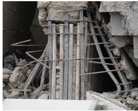
写真-1 柱脚重ね継ぎ手部（İskenderun）
