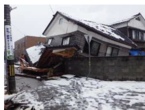
写真19 全壊した木造建物
