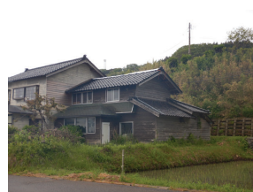
写真 22 瓦屋根の被害
