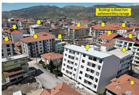
図-31 大きく傾斜した構造物（手前の白い建物）
