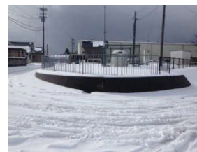
写真22 観測点近傍の段差
