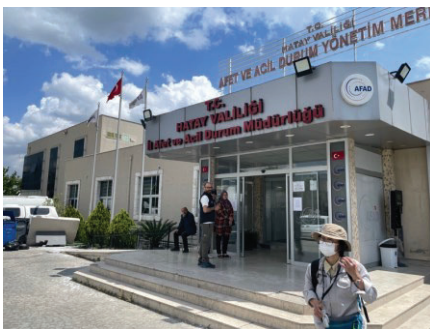
写真-7 ハタイ県災害対策センター
