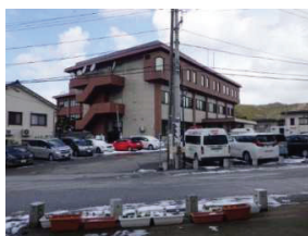
写真 9 輪島市役所 門前総合支所
