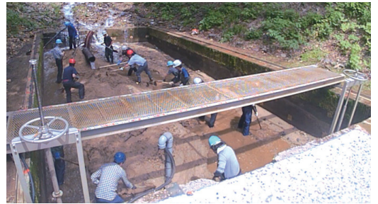
写真2 ヒル谷試験堰堤での土砂出し作業の様子
