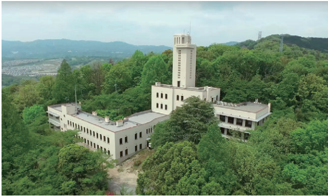
写真1 2階建ての西館（左側）と3階建ての本館からなり、本館からはさらに高塔が聳える
