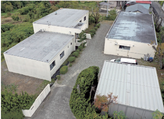
写真1 徳島地すべり観測所の全景
