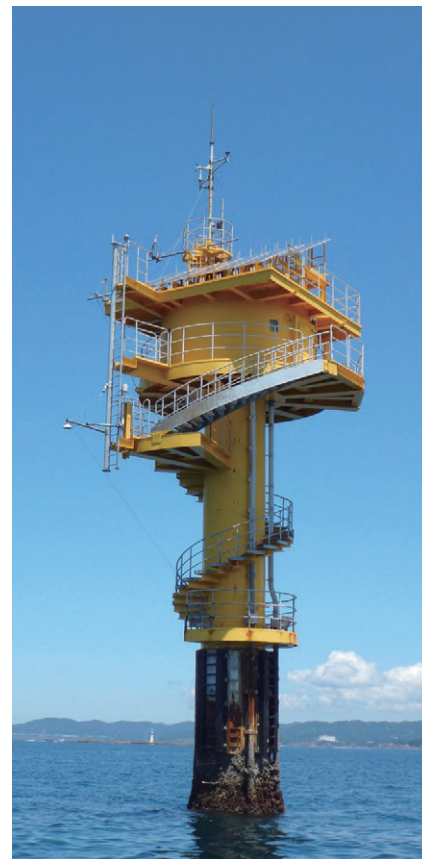
田辺中島高潮観測塔
