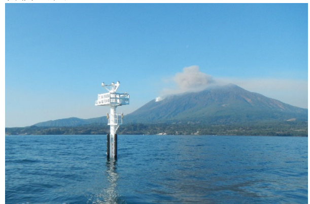
海底地盤変動観測装置
