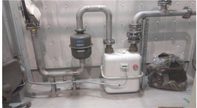
図5 ガスバッグ入口のオイルフィルター
