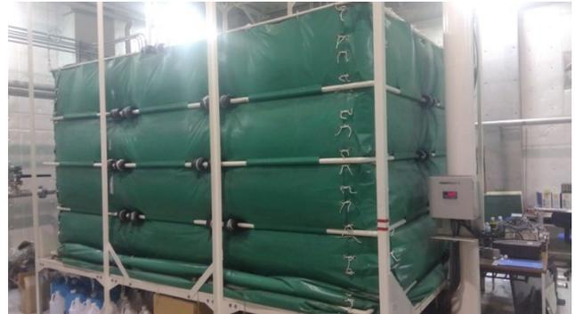
図 1 ヘリウム回収ガスバッグ
