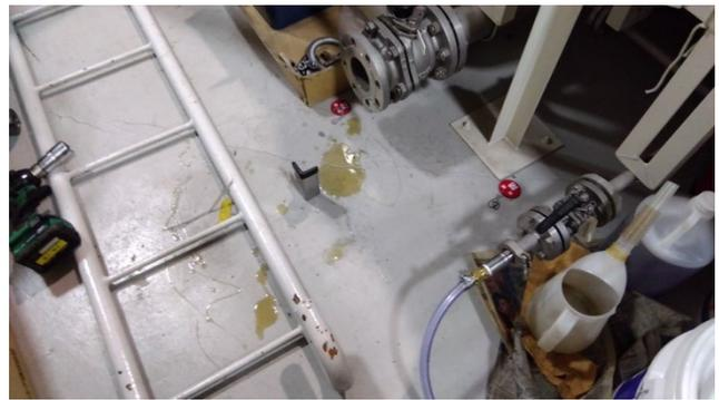
図8 ガスバッグ入口配管からの油漏れ
