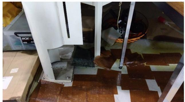
図 2 ヘリウム回収ガスバッグから油漏洩
