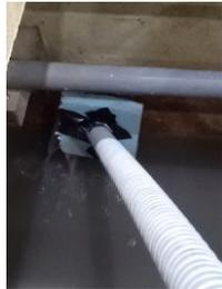
図5 埋設排水管出口を一時的に閉鎖
