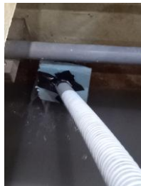
図5 埋設排水管出口を一時的に閉鎖
