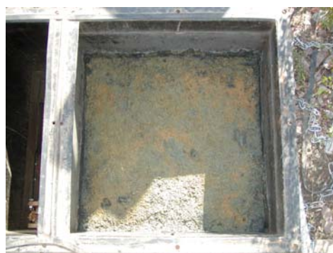
Fig. 5-8 回復作業後の土壌処理槽
