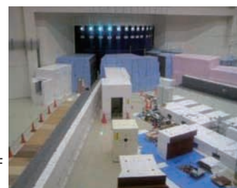
図3 建設中のJ-PARC/MLF 中性子実験ホール。
