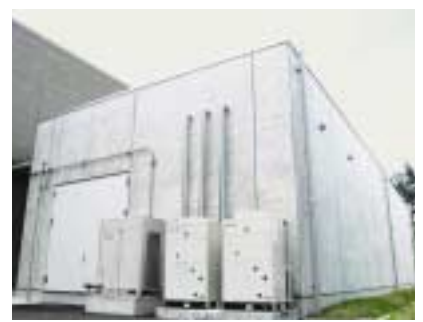
レーザー科学棟外観
