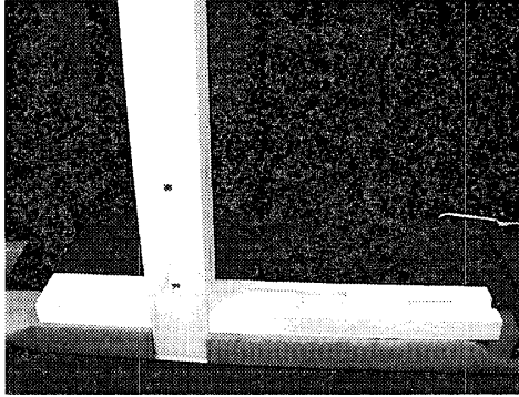
1. 柱に鴨居を取り付ける
