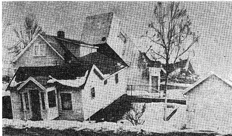
写真3 地氾り地帯で前方の木造家屋はほとんど破損していないが、後方のリフトスラブ式コンクリートビルは崩壊した 29) (アラスカ地震)
