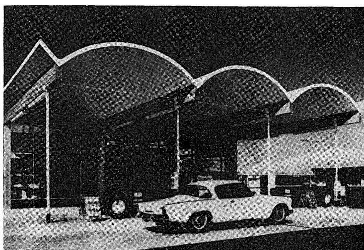
写真5 ガソリンスタンドの合板アーチ屋根，曲面のスパン約14呎，長さ15呎，桁は集成材 (Wood, 27, (1), 49, (1962))
