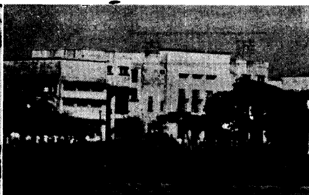
チュラロンコン大学構内の医科大学薬学部の建物
