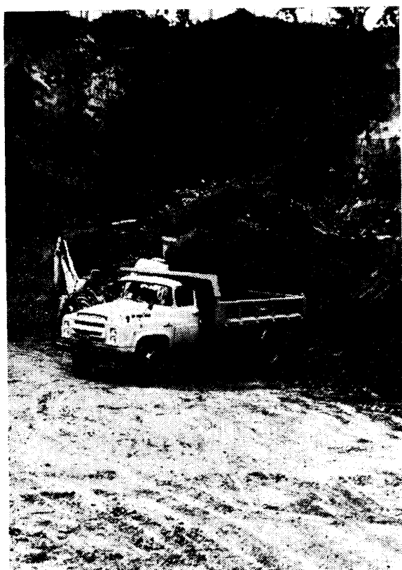
写真12 マンガン鉍石の採掘現場で、ショベルで楽に採掘されている。
