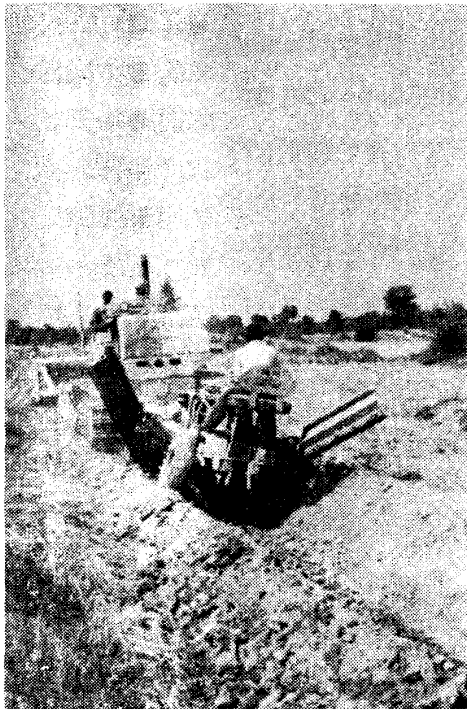
写真10 Suphanburi における Dykes and Ditches Project の機械による 施工状況
