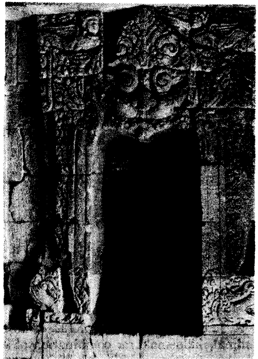
写真 8 前室のニッチ
