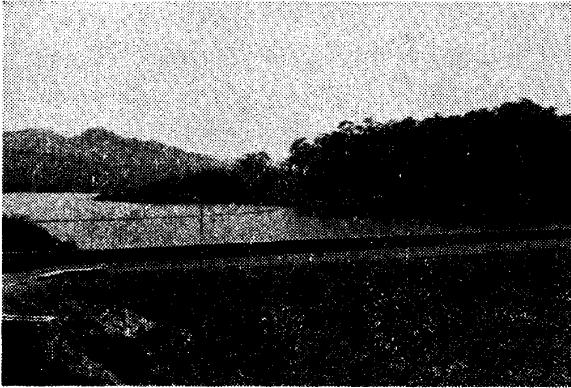
写真2 Pedu ダム（ロックフィルダム）
