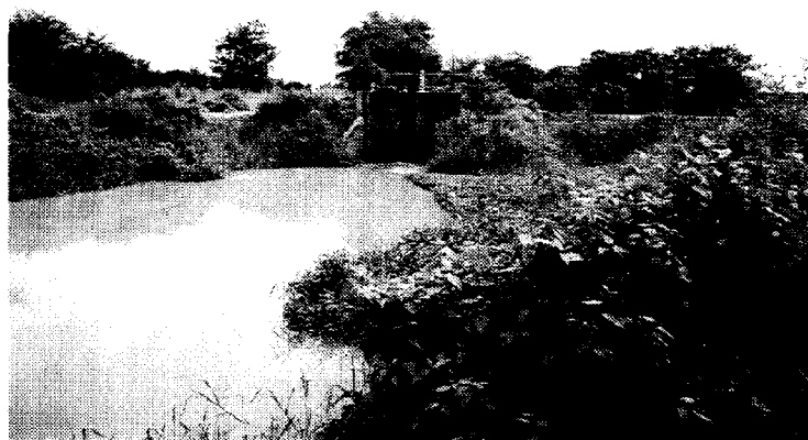
Photo 1 Drain Regulator (km 21 + 300)
