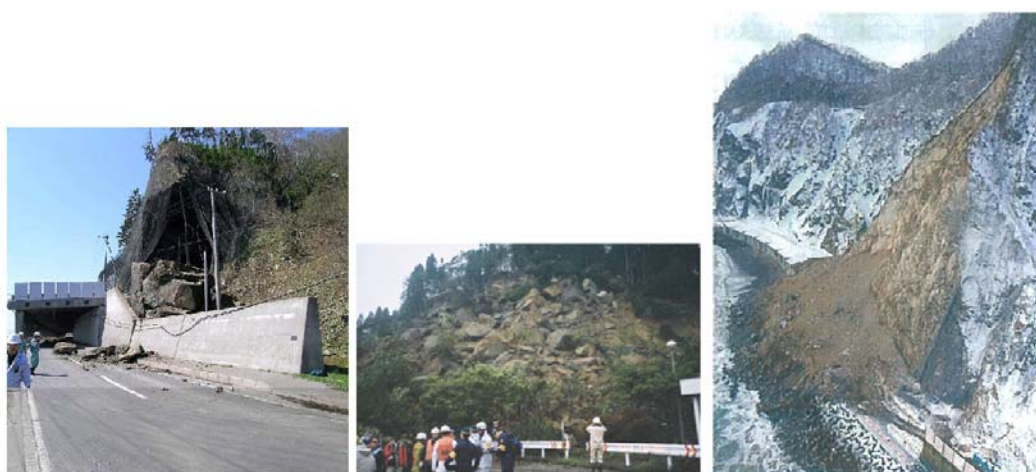
北浜岩盤転倒崩壊
