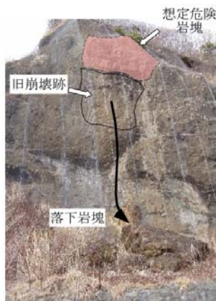
図 3.5.2 崩落跡と上部の危険岩塊
