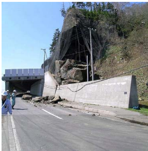
写真-2.1.6 海岸沿いの高さ 20~30m の崖面で発生した転倒崩壊. 崩壊高さ 25m, 最大幅 15m, 崩落土量(550m 3 ). ロックシェッド端で発生.
