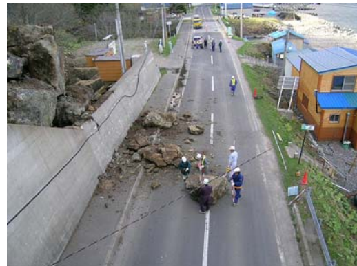
写真-2.1.6 海岸沿いの高さ 20~30m の崖面で発生した転倒崩壊. 崩壊高さ 25m, 最大幅 15m, 崩落土量(550m 3 ). ロックシェッド端で発生.
