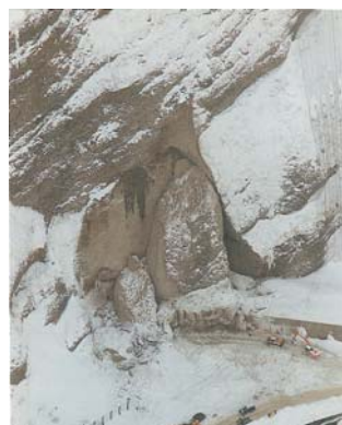
写真-2.1.2 豊浜トンネル坑口(1996) 崩落岩塊の規模は高さ 55m, 幅 30m, 奥行き 13m, 体積 7200m 3 .
