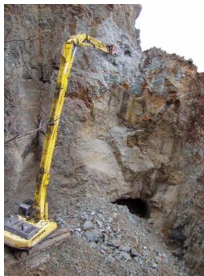
図4.2.4.2 現場(a)全景
