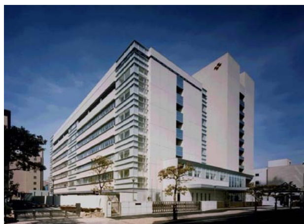
図 5.2 対象建物の概観
