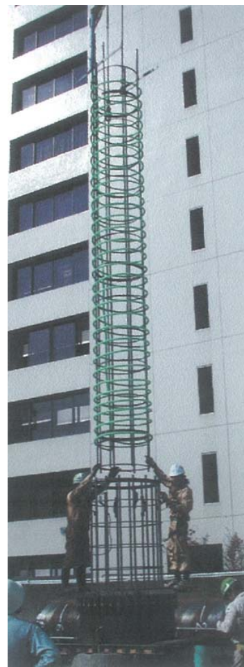
図 5.6 基礎杭施工の様子
