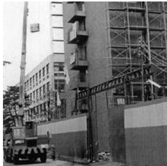
クレーンでコンテナを吊り上げての図書移転
