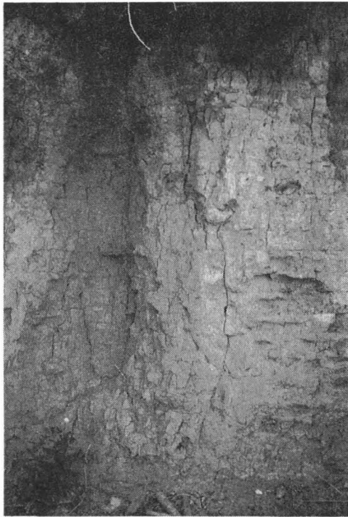
圖18 夯土層 隋唐洛陽城外郭城北牆 寬14—18cm, 厚13cm (筆者撮影)
