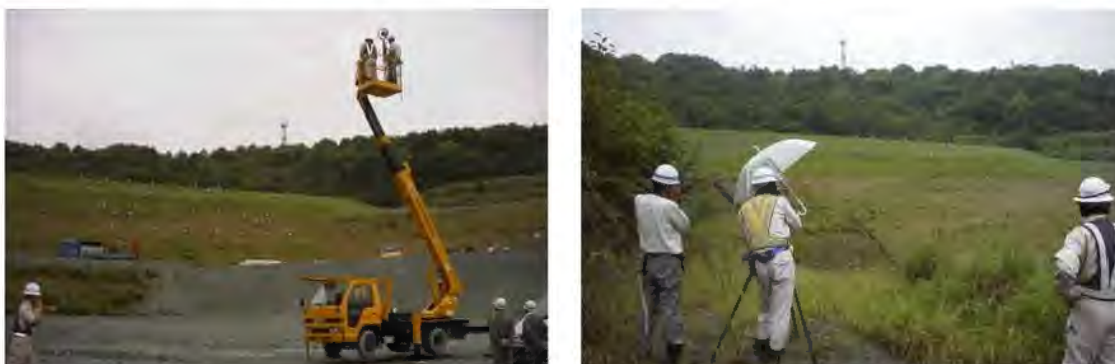
図 5.13 現地計測状況
