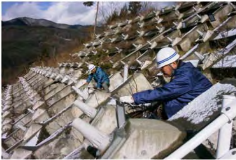
図 4.24 鋼巻尺測定状況
