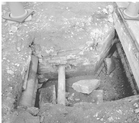
6 329a地点煉瓦組水路確認状況（南から）
