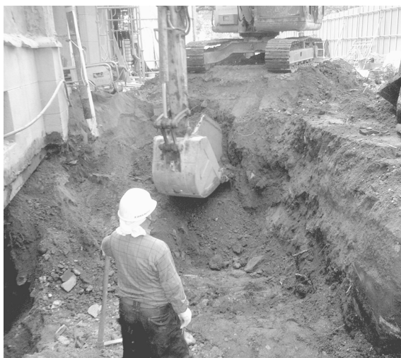
3 329b地点掘削状況（東から）
