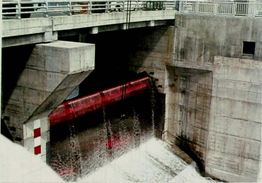
写真-5. 4 寒河江ダムフラップゲート越流流況(越流水深10cm)
