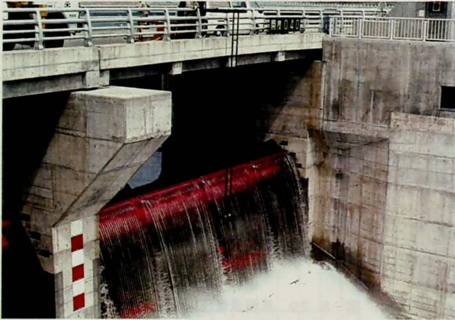
写真-5. 5 寒河江ダムフラップゲート越流流況(越流水深30cm)
