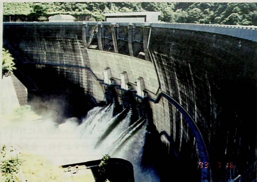
写真-2.7 アーチダムの高圧ローラゲート放流流況(天ヶ瀬ダム)
