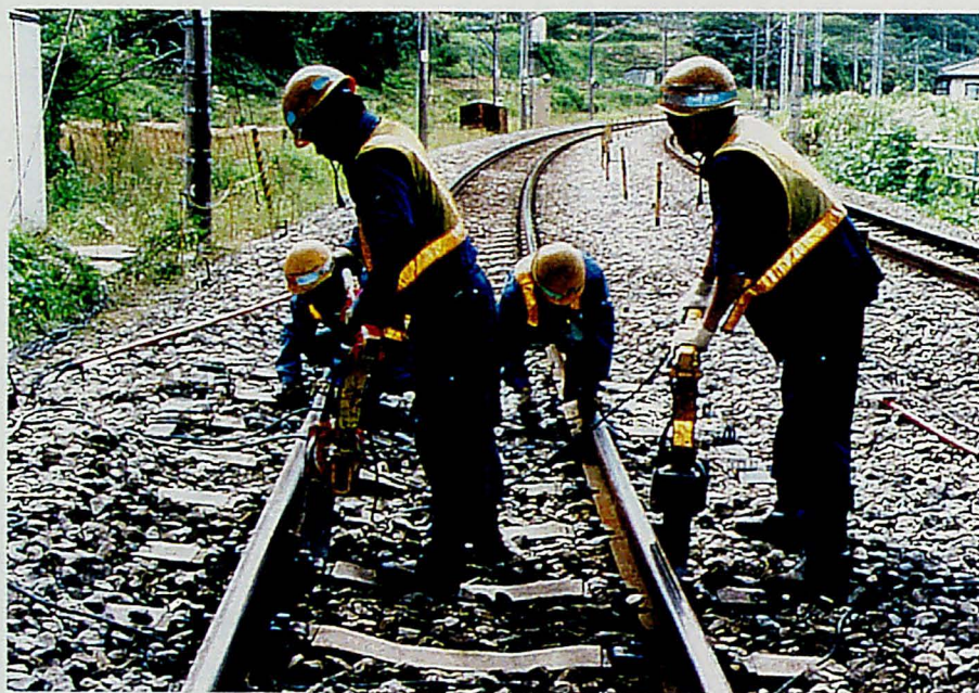
図3-1-2 道床つき固め作業
