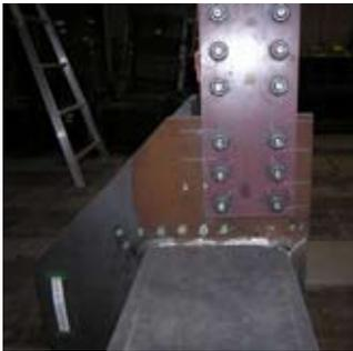
(a) 偏心側の鋼管, 外ダイアフラムの破断
