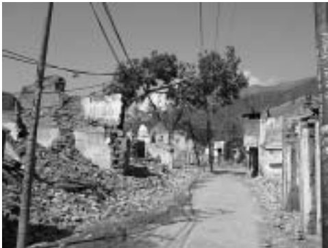
写真1 テーリーの町、家の残骸が並ぶ (2003年2月28日筆者撮影)
