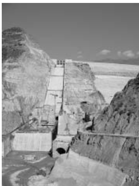
写真5 完成間近のテーリー・ダム (2004年12月12日筆者撮影)
