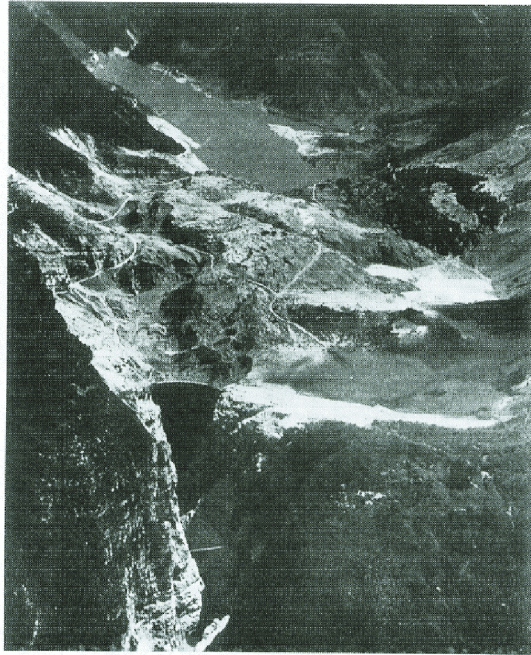
図-5 崩壊後のバイオントダム
