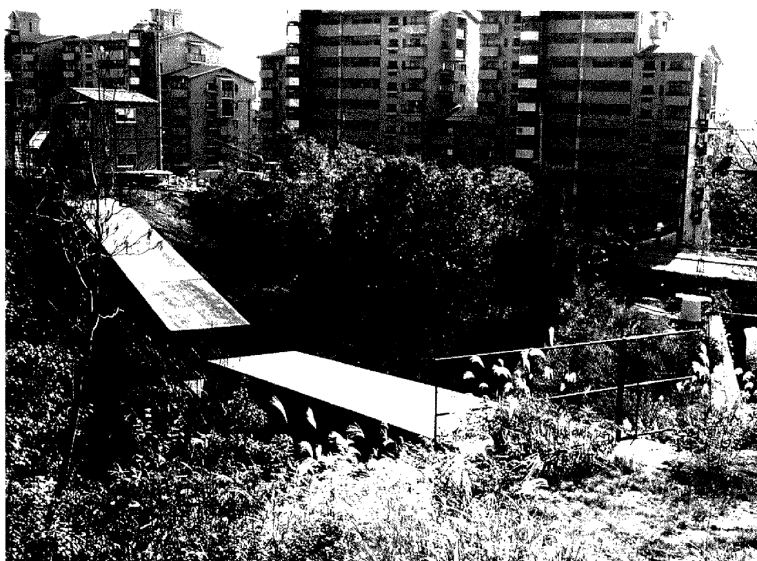
如意谷砂防ダム工（箕面市）
