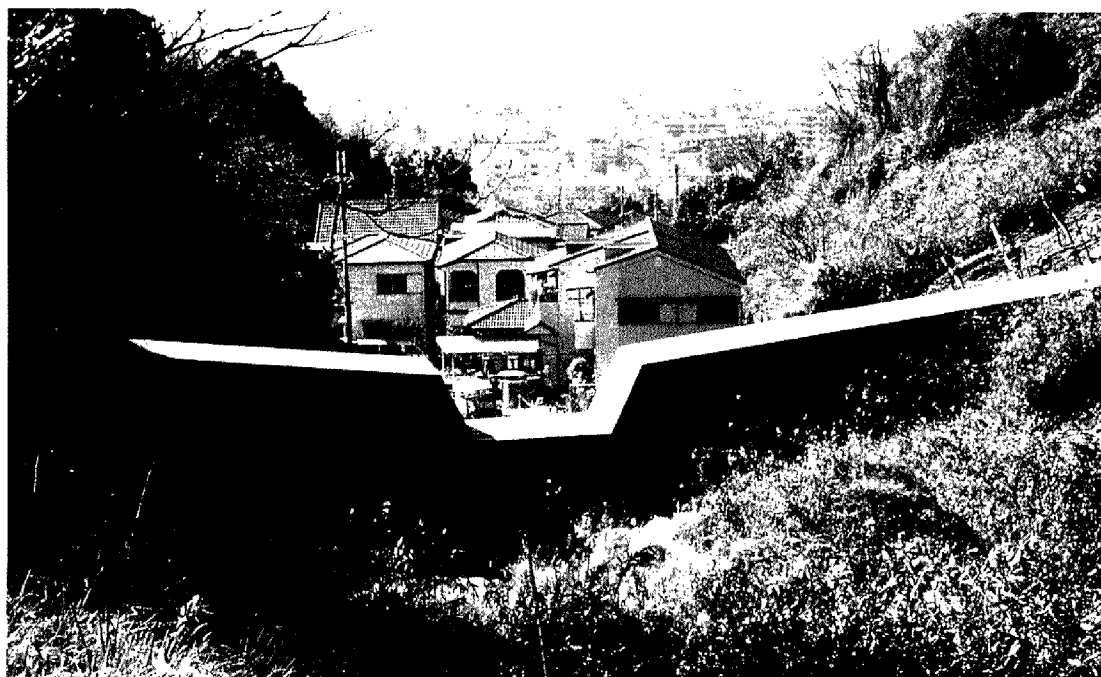
谷山溪砂防ダム工（柏原市）
