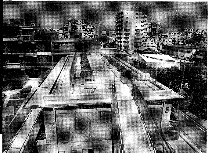
5棟の緑化スペース(北側)
