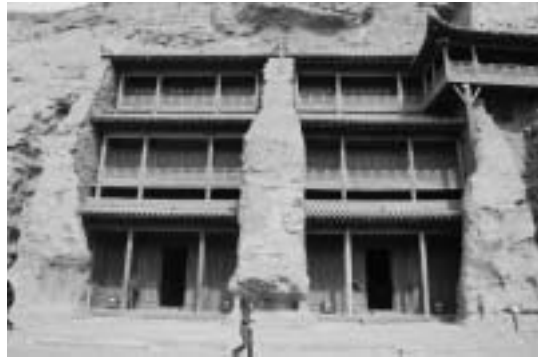
圖 31 雲岡石窟第 7・8 窟外壁大石柱及び木造建築
