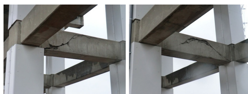
写真4 東北新幹線仙台駅－古川駅間の高架橋横梁の損傷（撮影日：2011/3/15）
