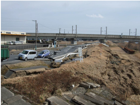
写真1 江合橋左岸下流側の堤防盛土の被害 (撮影日：2011/3/14)
