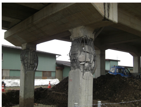
写真3 東北新幹線北上駅－新花巻駅間の第1中曽根BLのラーメン高架橋柱の大きな損傷（撮影日：2011/3/15）
