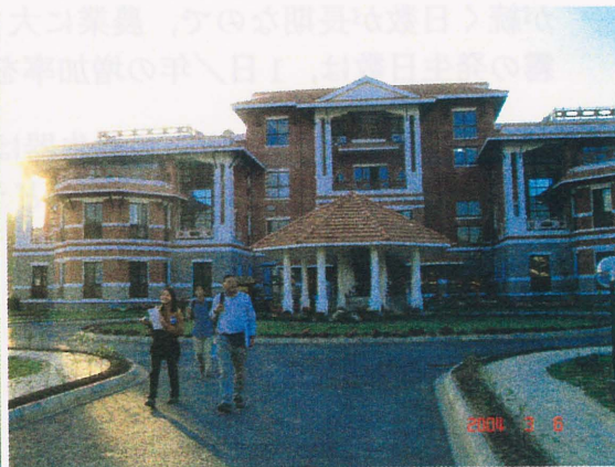
図 3: ICIMOD ビル外観
