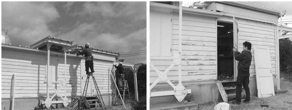
(左) 屋根樋の設置 (右) 入口扉の取替
