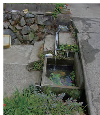
⑰水槽(南川)
