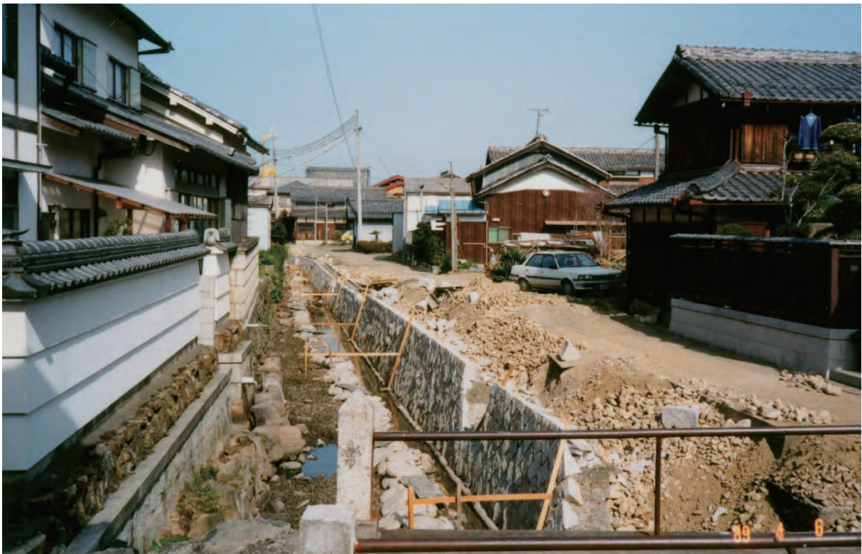
写真46 伊庭川の道路拡幅工事(福島崇雄氏撮影、1989年4月)
