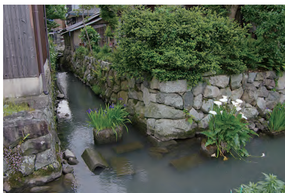
②③伊庭川の石垣(西殿)
