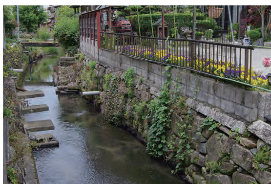
②⑨集落内水路の石垣(南川)
