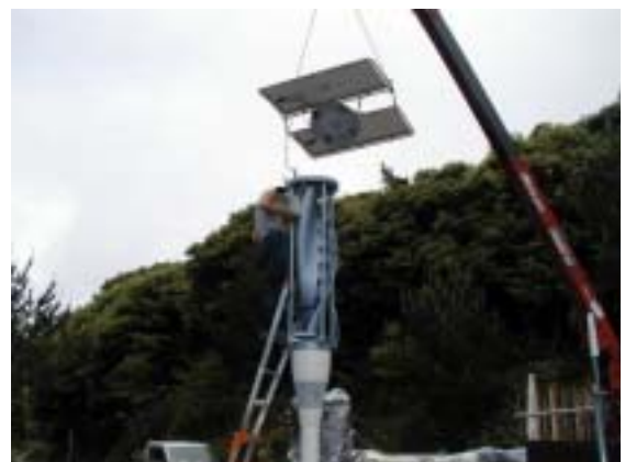
写真 4. ソーラパネル取り付け
