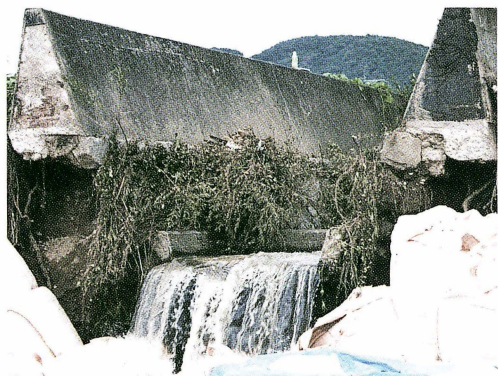
図22 河川堤の破断面（8月15日）
