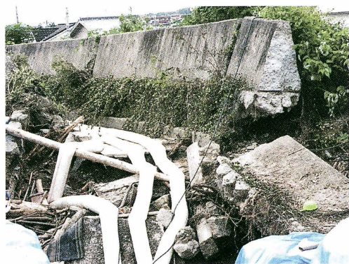
図23 ポンプによる排水（8月15日）
