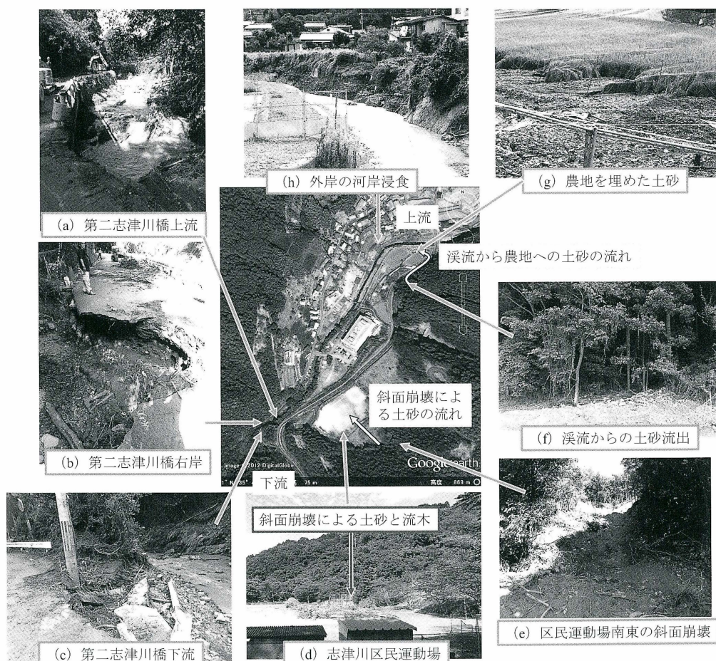
図11 蛭橋下流域の被災状況
