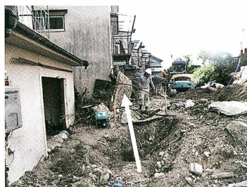
(b) 倒壊した堤防壁
