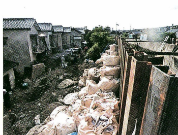
(a) シートパイルの施工
