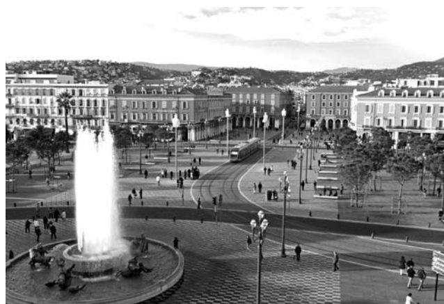
▶写真4 整備後のマセナ広場
