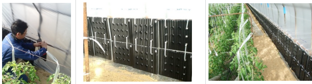
Fig.6 PCMの設置状況
