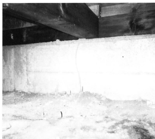
図7：住宅床下の基礎表面につくられたシロアリの蟻道(中央部)
